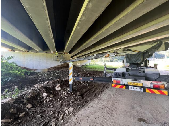
고소점검차를 이용한 근접조사
