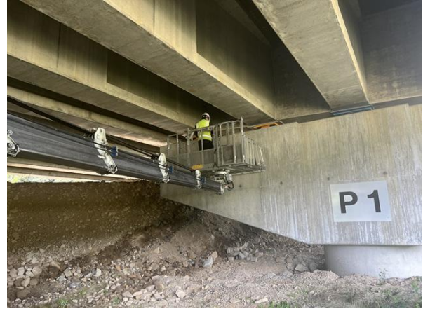
고소점검차를 이용한 근접조사
